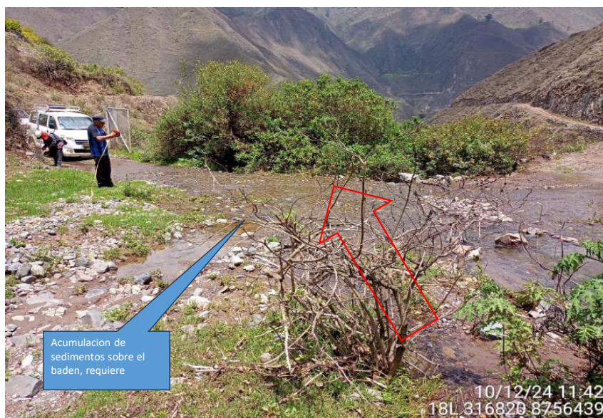
FIGURA N°03: EN LA TEMPORADA DE MAXIMAS AVENIDAS, LA QUEBRADA CALLAHUANCA SE SEDIMENTA Y REALIZA DESVIO DE AGUAS OCACIONANDO, DETERIORO DE LA CARRETERA.
